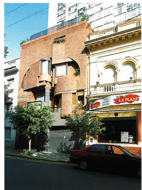
P. T. Beitia, woonhuis Avenida Serrano, Buenos Aires (Argentinië)
