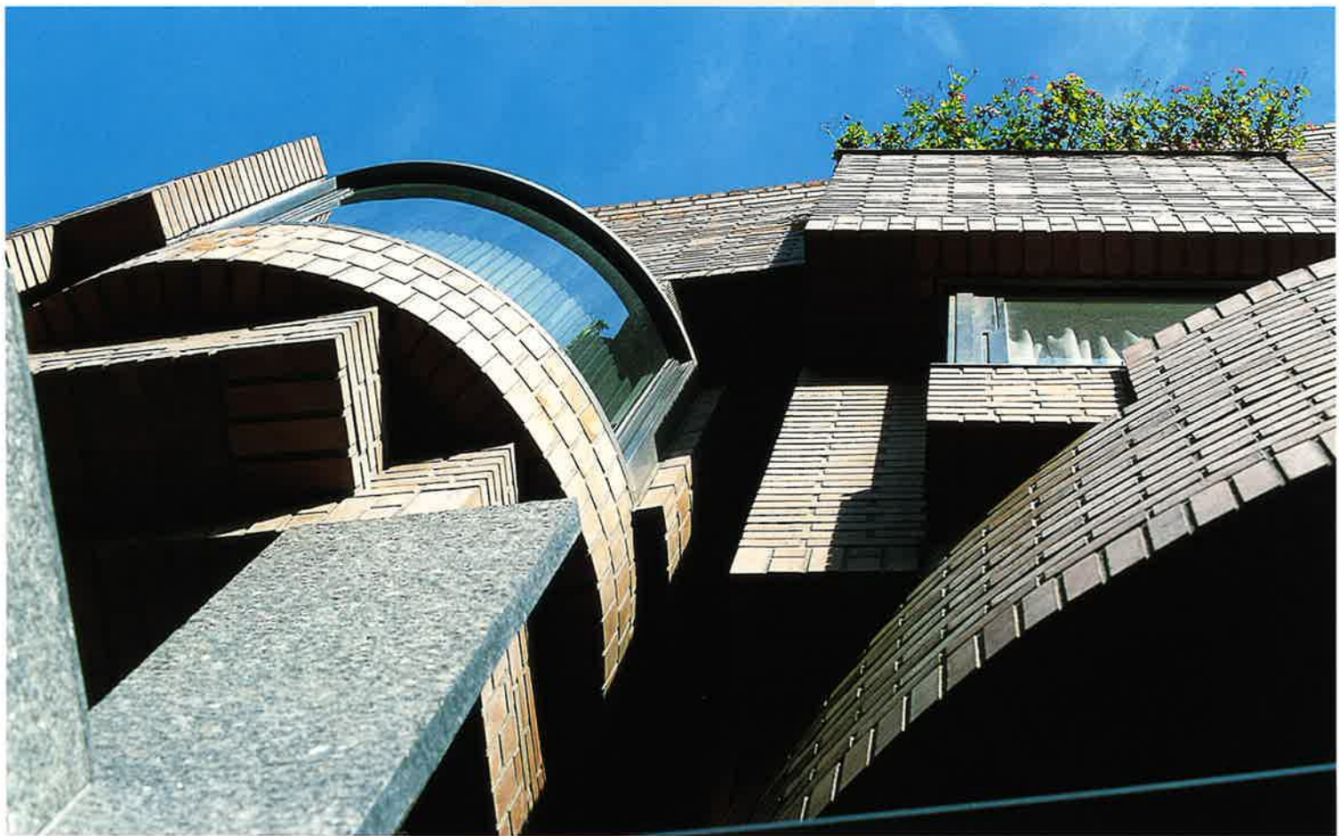
P. T. Beitia, woonhuis Avenida Serrano, Buenos Aires (Argentinië)
